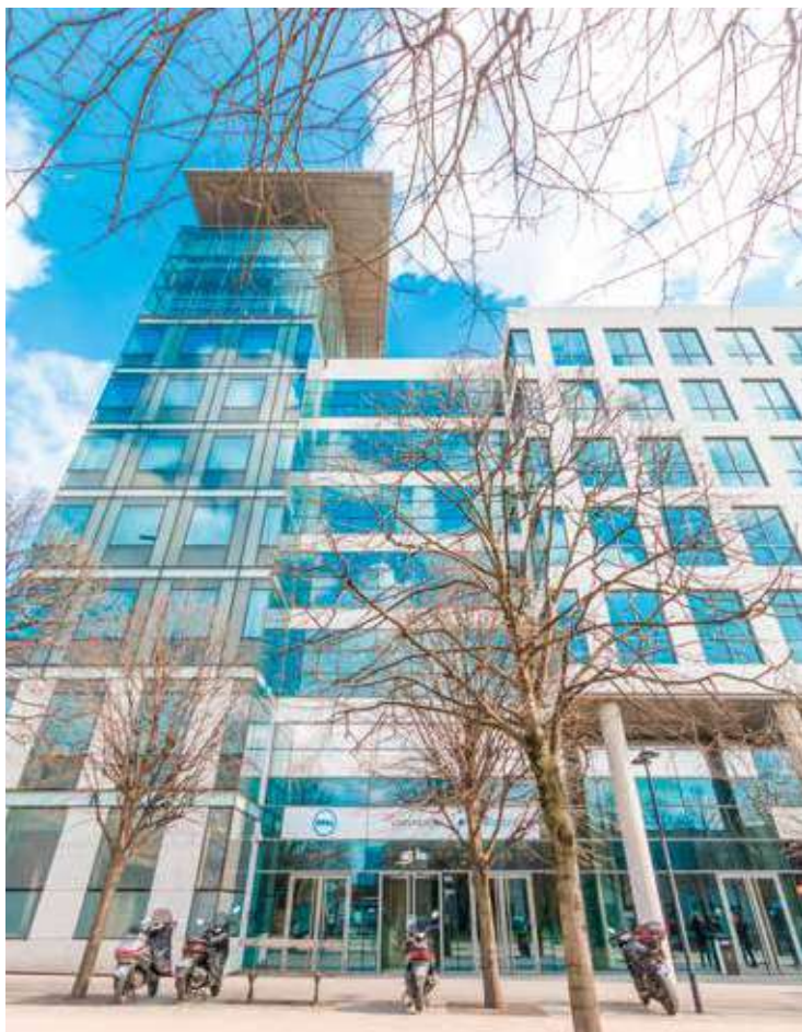
Les Portes de France – Saint-Denis (93) Acquisition 2015
