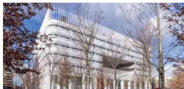
Immeuble « Influence 2 » - Saint-Ouen (93)
